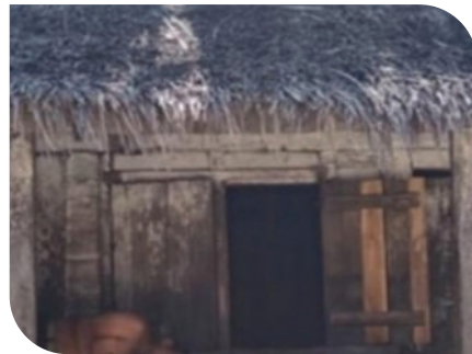
Gambar 2.16 Rumah dengan konstruksi kayu di Desa Nuwewang Sumber: Pakniany (2022)
