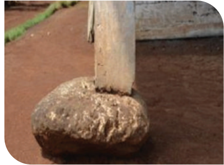
Gambar 2.13 Tiang Rumah di atas Umpak Sumber: Ristiyati/ Kemendikbud (2020)
